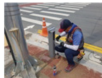
〈센서 Pole 설치〉
